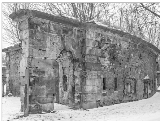
Ryc. 1. Przykład elementów fortyfikacji stałych: Twierdza Warszawa / Cytadela Warszawska (Aleksandrowska): kaponiera / bastionu – z lewej; półkaponiera – z prawej (fot. R. Zapłata)
