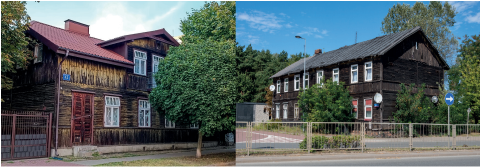
Ryc. 3. Zabytkowe „drewniaki” dzielnicy Targówek. Do czasów współczesnych pozostało ich zaledwie kilka. Po lewej: drewniak na ul. Siedzibnej. Po prawej: drewniak przedsiębiorcy Paprockiego przy rondzie Żaba. Autor: M. Osiak
